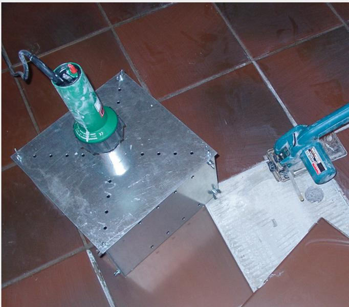
*Zerstörungsfreies Aufnehmen von Fliesen mit SysTeSan und dem Heißluft-Gebläse ELECTRON von Leister.*
