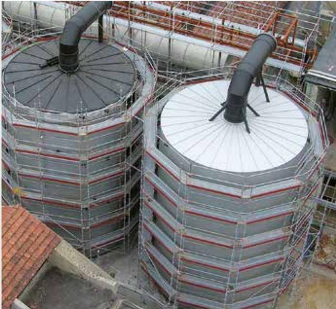
Luftreinigungsanlage, Spanien. Material: HD-PE
