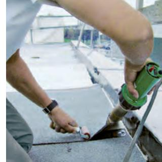
Der leistungsstarke ELECTRON mit Breitschlitzdüse beim Verschweissen von Bitumenbahnen.
