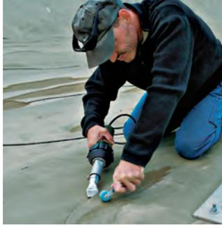
Verschweißen der Anschlüsse mit TRIAC PID und aufgeschobener Breitschlitzdüse.
