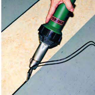
Der TRIAC S beim Verschweißen von Linoleum, ausgerüstet mit einer Schnellschweissdüse.
