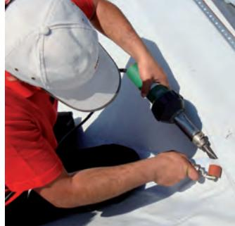
Verschweißen eines Patches mit dem TRIAC PID auf einer Baustelle.
