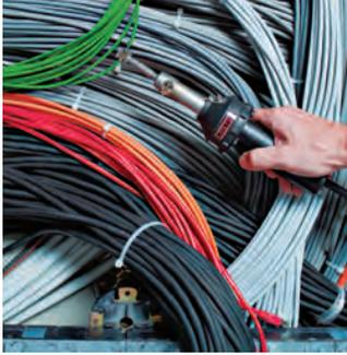
Anbringen einer Lötshrumpfverbindung mit HOT JET S und aufgeschobenem Siebreflektor.
