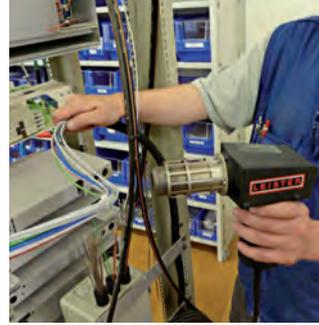
Erwärmung von Glasfaserbündeladern zur einfacheren Verarbeitung
