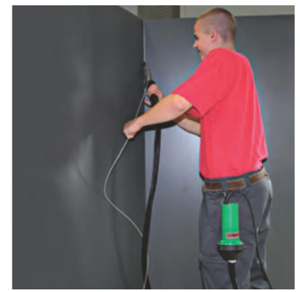
Gebläse MINOR als Luftversorgung für die DIODE PID.
