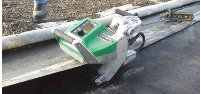
Der GEOSTAR schweisst im Feldtest (Südafrika) mühelos 240m in einem Arbeitsgang.
