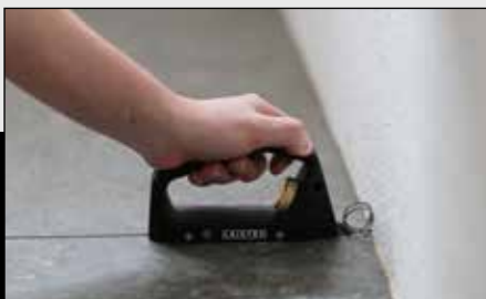
Ausführen sauberer Fugen bis zum Wandabschluss
