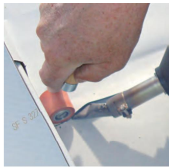
Der kleine und leichte HOT JET S eignet sich perfekt bei engen Platzverhältnissen.
