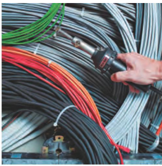
Anbringen einer Lötshrumpfverbindung mit HOT JET S und aufgeschobenem Siebreflektor.
