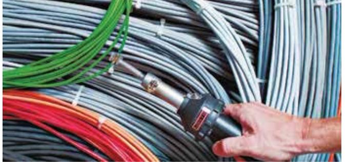
Anbringen einer Lötshrimpverbinding mit dem HOT JET S und aufgeschobenem Siebreflektor.
