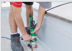
Attika-nahes Schweißen an Lichtkuppeln
