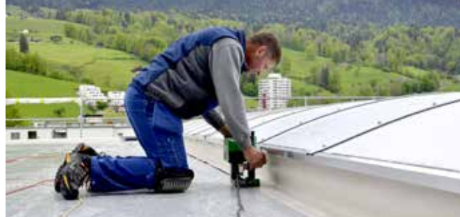
Ob auf und an der Attika, zum Verschweissen von Lichtkuppeln, Anschlüssen oder kleinen Terrassen – der UNIDRIVE 500 überzeugt auch bei wenig Platz.
