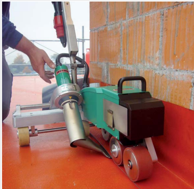
Durch die schlanke Bauweise ist Schweißen bis 100 mm Wandabstand möglich.
